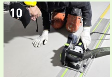
Zugelaufene Dehnungsfugen mit dem DSC AG 125 und der Führungsschiene auftrennen. TIPP: Bei längeren Dehnungsfugen lassen sich mehrere Führungsschienen verbinden.
