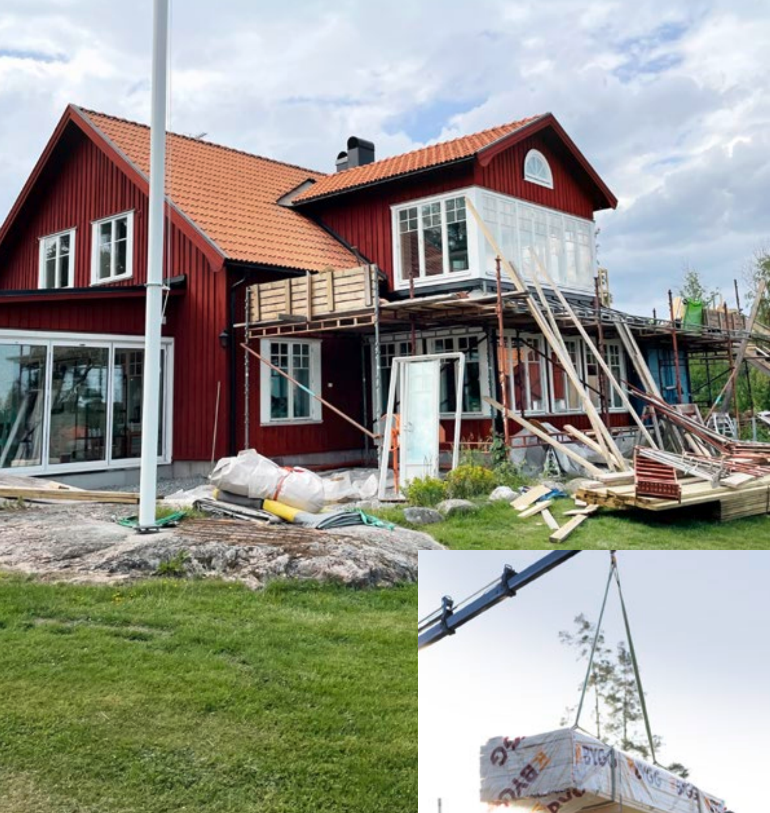
↑ Langzeitprojekt: Das Haus am See hat Patrik Hansson 2006 mit seinen damaligen Chefs gebaut. Die Arbeiten an der umfangreichen Erweiterung begannen 2021.
