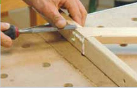
6. Entfernen Sie alle Kleberreste mit einem scharfen Stemmeisen und schleifen Sie raue Stellen mit einem Exzentrerschleifer und einem Handschleifklotz nach. Der letzte Schliff vor der Oberflächenbehandlung sollte mit Körnung P 180 ausgeführt werden. Mit einem witterungsbeständigen Öl wird der Tisch zunächst einmal komplett behandelt. Wenn dieser erste Auftrag trocken ist, wird mit Schleifpapier
