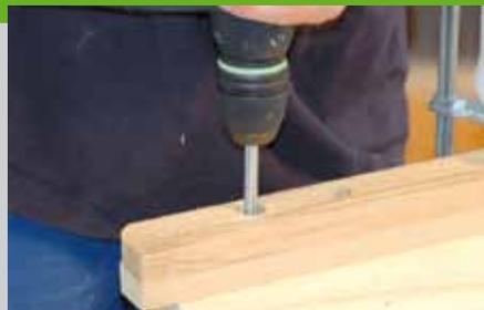
bohren oder die Leiste auf einem Restholz festspannen. Bei den beiden Sacklöchern, in die der Aluminiumstab (Pos. 8) eingeklebt wird, müssen Sie die Bohrtiefe (10 mm) möglichst genau einhalten. Montieren Sie dazu entweder einen Tiefenanschlag an den Bohrer oder messen Sie während des Bohrens nach.
