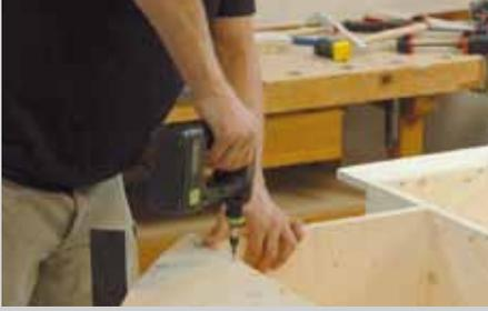
3. Die Front- und Heckbodenplatten (Pos. 8) werden parallel zum Deck ausgerichtet und festgeschraubt. Deck und Unterbau werden von unten mit quadratischen Leisten miteinander verbunden.
