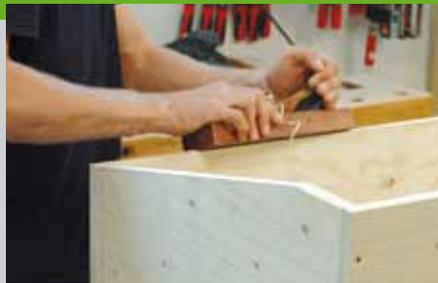
Das Frontbrett (Pos. 2) kann entweder vorher mit einer Kreissäge schräg geschnitten oder alternativ schräg gehobelt werden. Auch in der Ablage (Pos. 4) werden  $3,5$  mm Löcher für die Spax-Schrauben vorgebohrt.
