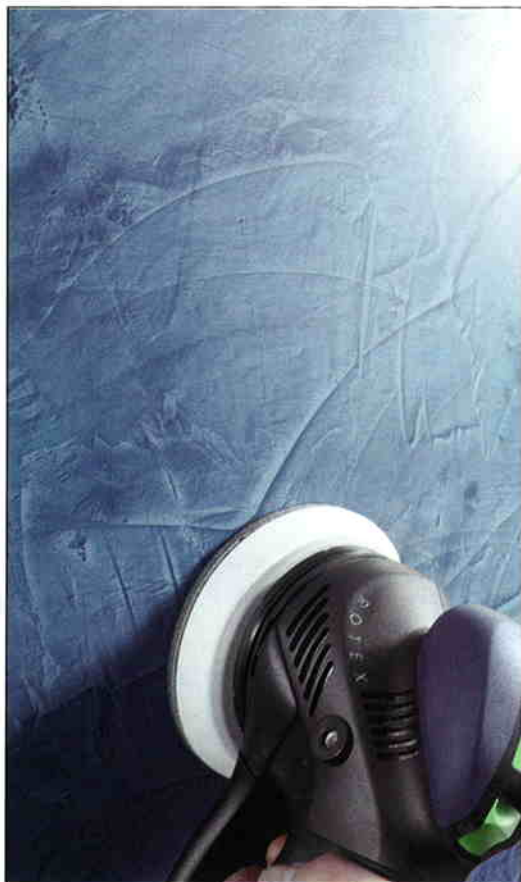
Mit einem Exzentrerschleifer können Spachtelflächen kraftsparend auf Hochglanz gebracht werden.
