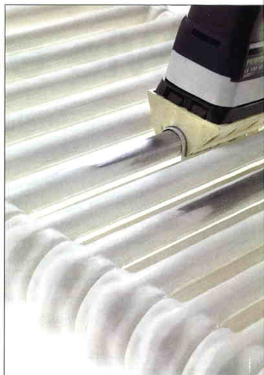
Für den Feinschliff bei Heizkörpern oder bei tragfähigen Altbeschichtungen wird ein feinkörnigeres Schleifmittel der Körnung P100-220 eingesetzt. Der dem Heizkörper perfekt angepasste Schleifschuh spart Zeit und Kraft. (Fotos: Festool)
