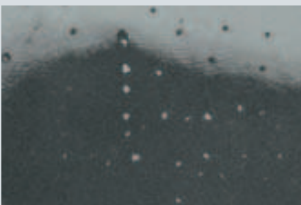
Oberfläche mit Kontaktkorrosion.
